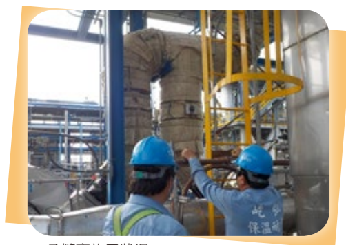
▲ 承攬商施工狀況
