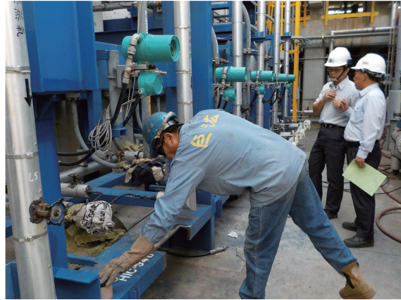
承攬商施工狀況
