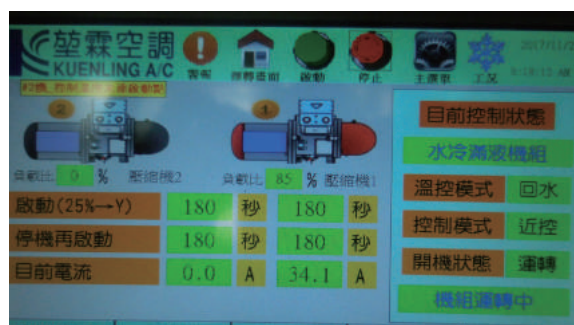
(辦公室冰水機汰舊換新)
