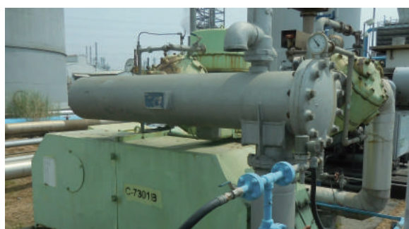
(C-7301 B 空壓機變頻節能汰舊換新)
