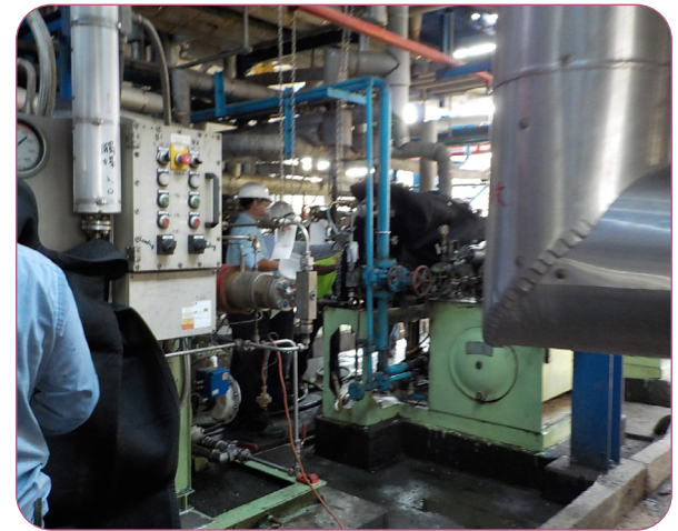
承攬商現場施工協調
