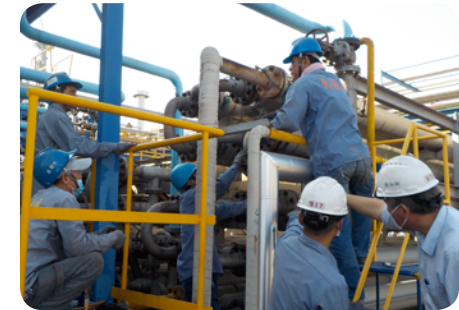
承攬商現場施工協調
