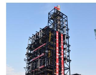
乙烯裂解爐整體模組搬運安裝
