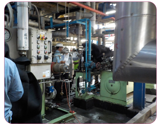
承攬商現場施工協調
