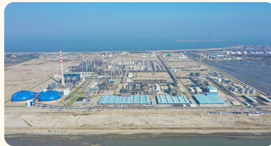
古雷煉化一體化項目主廠區全景
