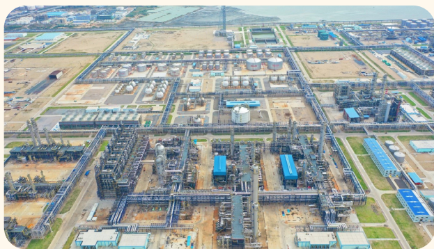
蒸氣裂解裝置
