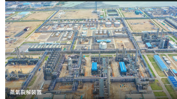
古雷煉化一體化項目主廠區全景
