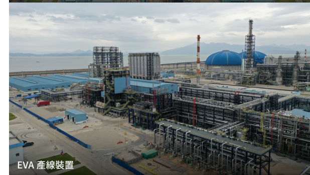
蒸氣裂解裝置
