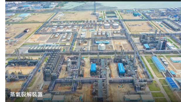
古雷煉化一體化項目主廠區全景
