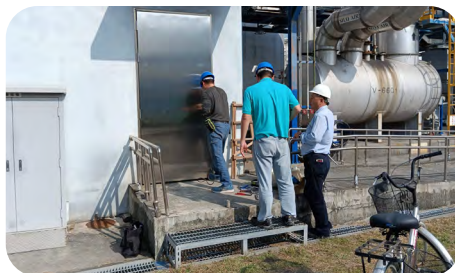
承攬商現場施工協調
