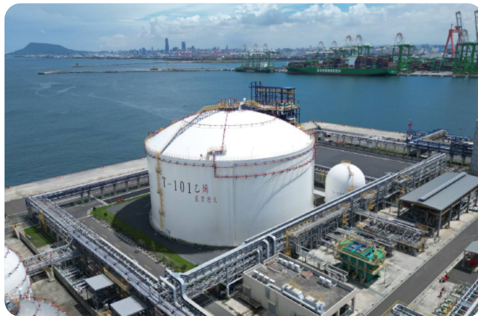
▲ 華運洲際二期廠區 - 乙烯儲槽區裝置
