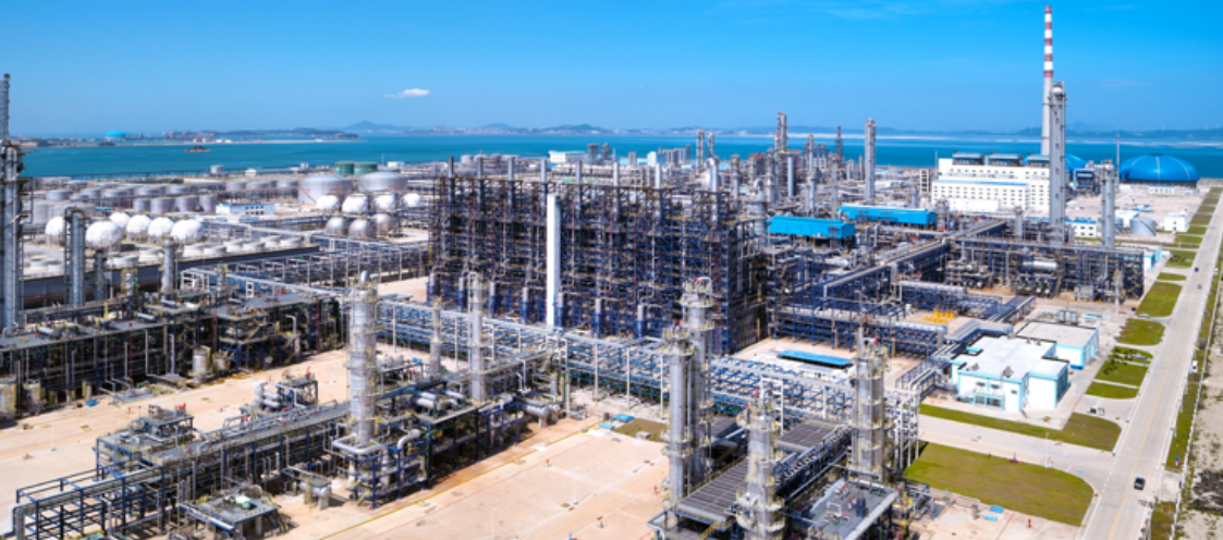
古雷石化 - 乙烯裂解裝置全景圖
